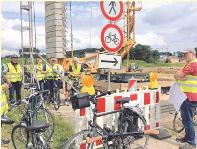
CDU Radtour 2016 an der Baustelle B51 Neu. Foto: CDU Belm
