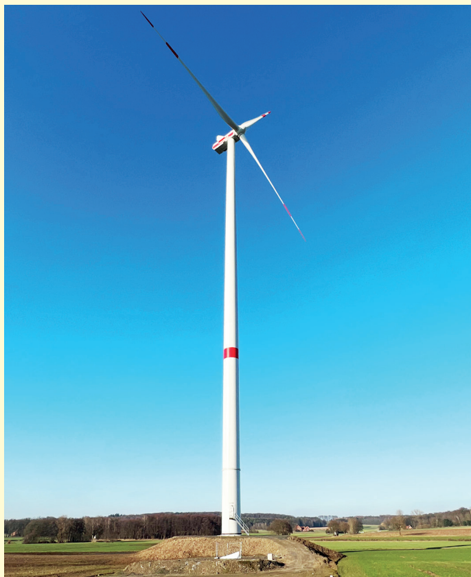
Die Nabenhöhe der Belmer Anlage vom Typ Vestas V112 beträgt 143 Meter. Foto: Wasserverband Wittlage
