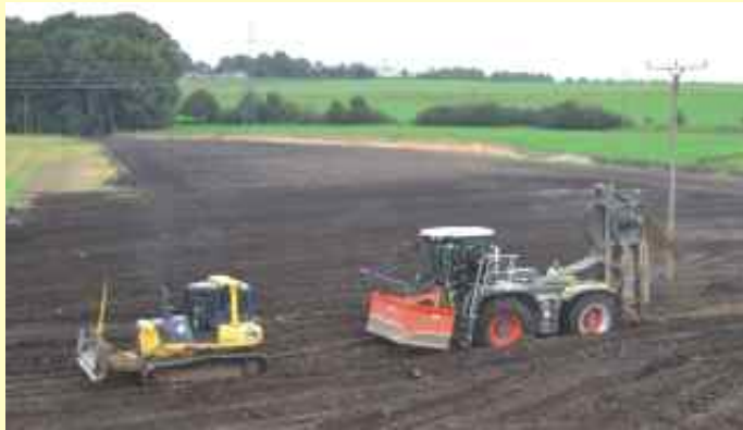
Spezialfahrzeuge im Einsatz: Eine Grabenfräse, zusätzlich von einer Planieraupe gezogen, bereitet den Graben für Drainagerohre vor. Etwa an dieser Stelle wird der nördliche neue Kläranlagendeich verlaufen.
