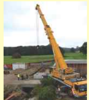
Mit einem KVN-Autokran wurde das rund 33 Tonnen schwere Betonbauwerk für das Hochwasserpumpwerk in den Verlauf des trockengelegten „alten“ Belmer Baches an der Kläranlage eingebaut. Zwei Tauchpumpen sorgen künftig mit je 100 Liter je Sekunde Pumpleistung dafür, dass das geklärte Abwasser auch bei Hochwasser abgeführt wird.
